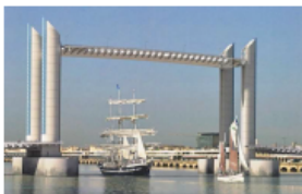
Octobre 2009 : début des travaux du pont levant de Bordeaux
