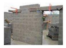
C'est un bloc de béton moulé, d'argile cuite. De forme régulière, solide, relativement léger et peu cher, le bloc est le composant principal des murs extérieurs. Ils sont assemblés par un mortier (liant). Le bloc de béton est généralement enduit (protection et décoration).
